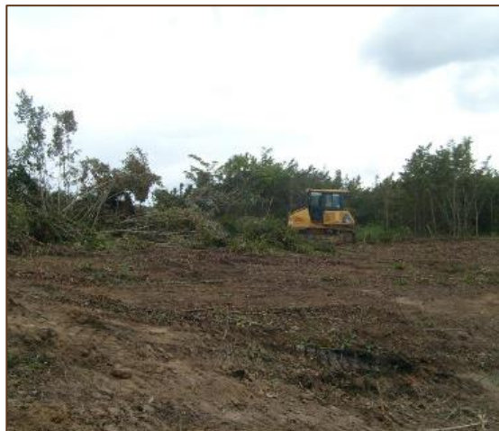
Imagem 3: Trator de esteira fazendo limpeza pesada e enleiramento com lamina frontal.
